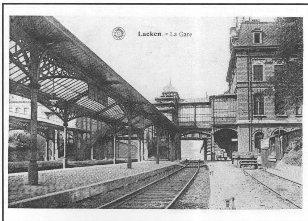
Spoorwegstation LAKEN 1920, symfonie in ijzer en glas
