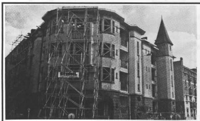
Emile Delvastraat (restauratiewerken aan beschermde gevelpartij)
