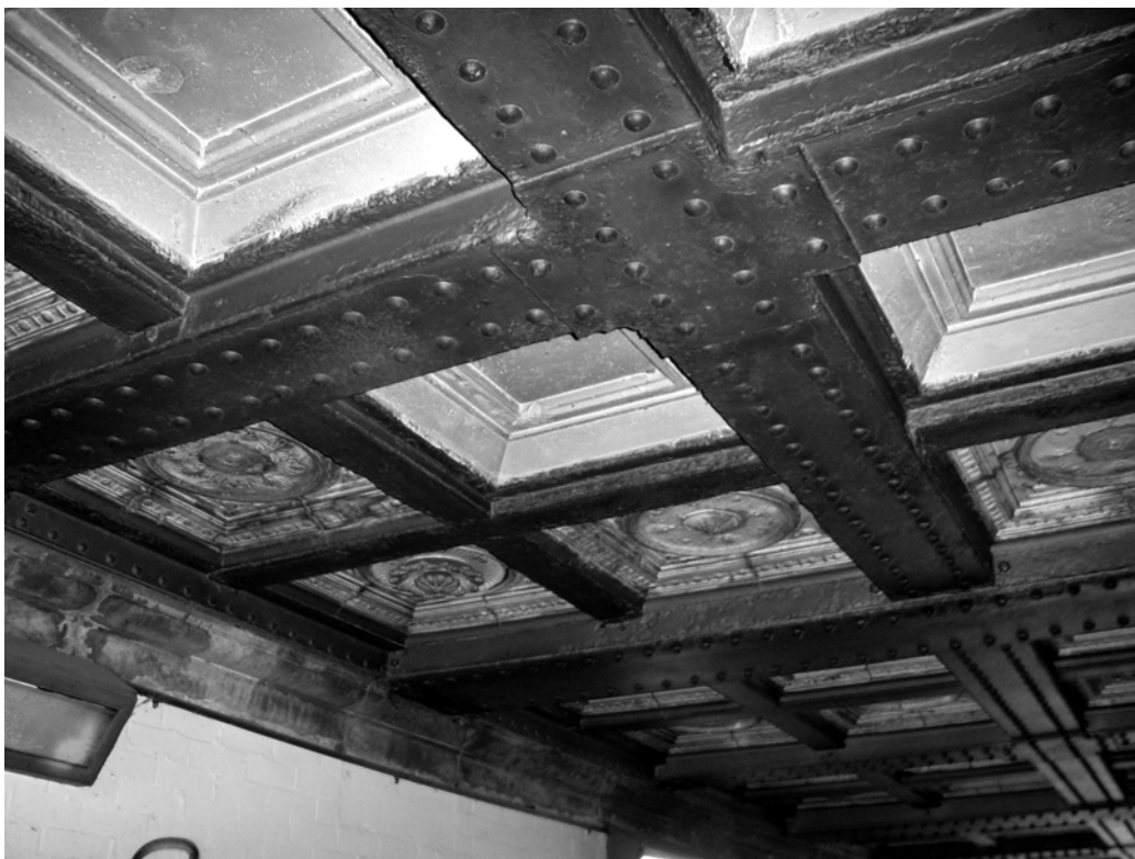
Binnenzicht tunnel (foto Steph Feremans)
