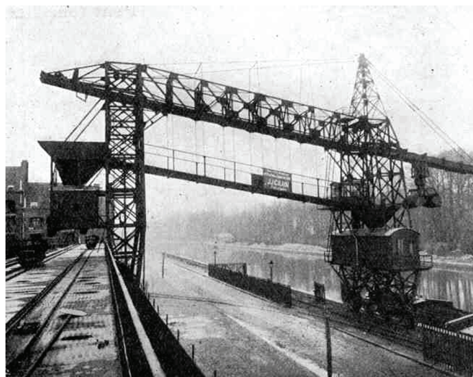
Losinstallatie voor steenkool (Port de Bruxelles 1927)
