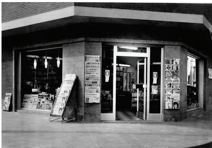
De nieuwe winkel aan de hoek van de Emile Delvastraat en de Steylsstraat
